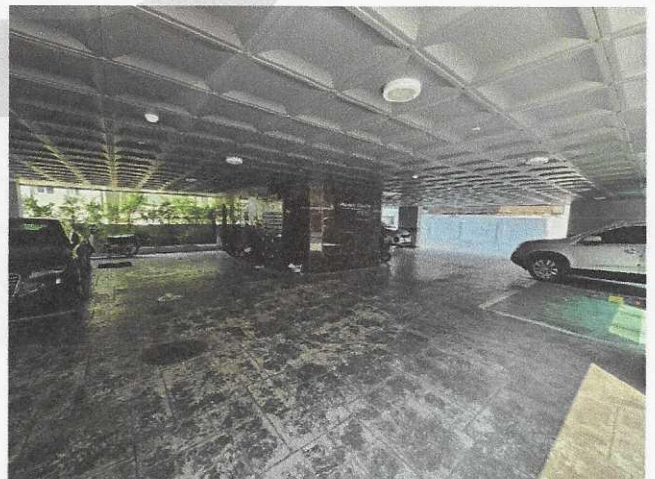
1층 현관 및 주차장
