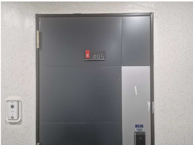
일련번호 1) 출입구 전경
