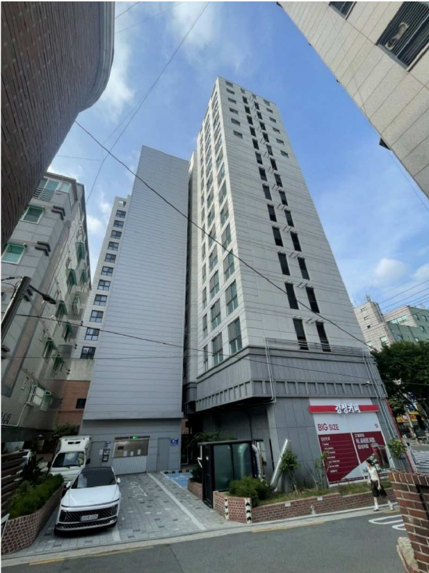
본건 소재건물 남측 전경
