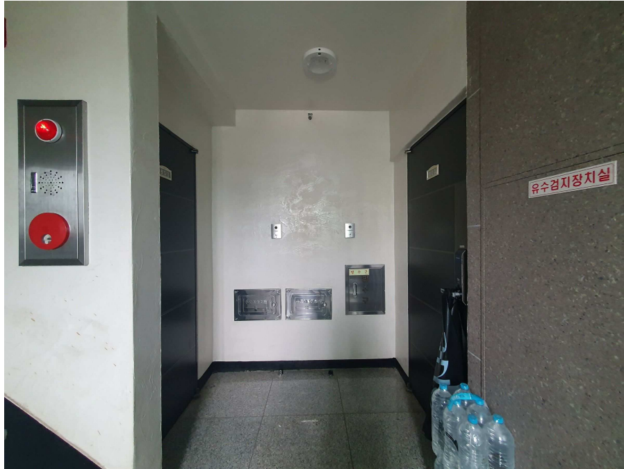
본건 앞 복도 전경
