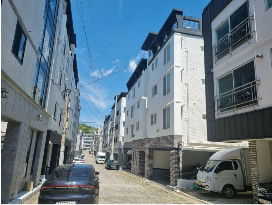
본건 전경 : 남동측에서 촬영
