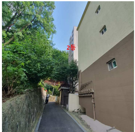
본건 북동측 인접도로 주위환경
