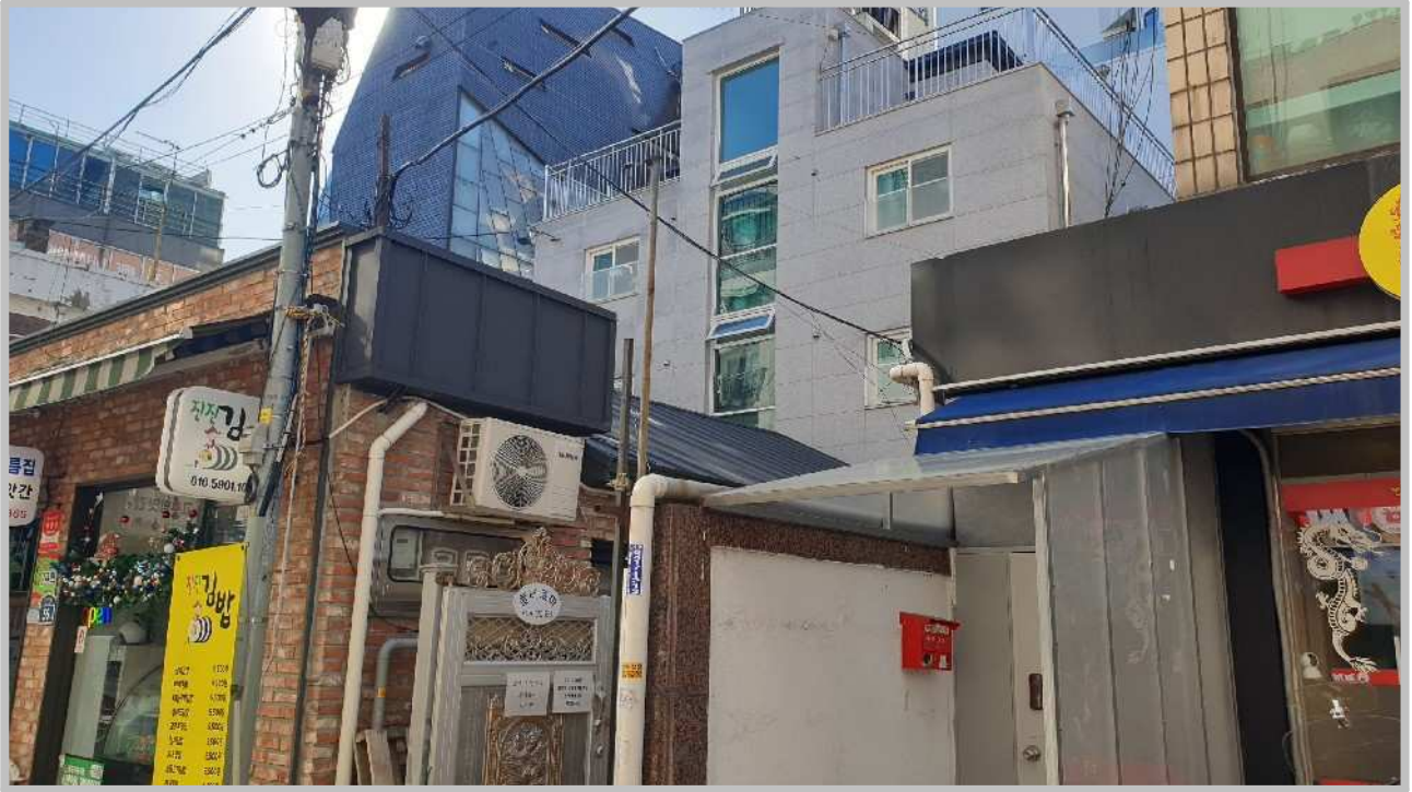
【 본건 및 주변 전경 】
