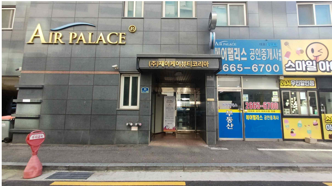
[본건 건물 공동출입구]
