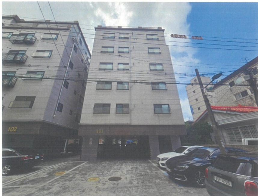
본건이 속한 건물 전경(후면)
