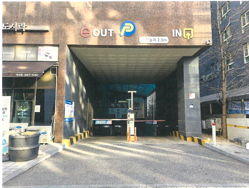
본건이 속한 건물 지하주차장 입구
