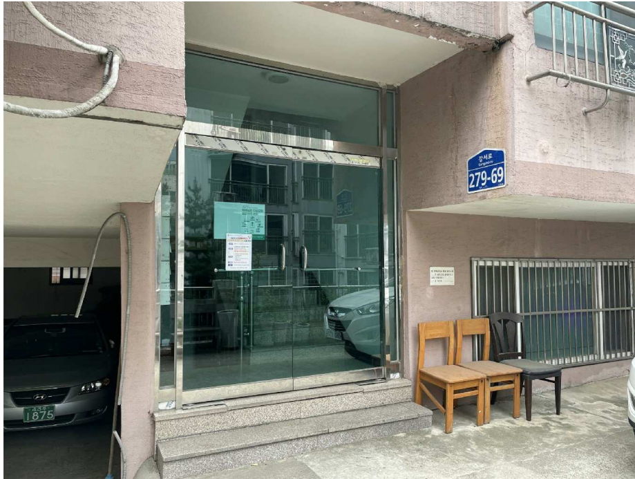
기호(1) 공동출입구 전경
