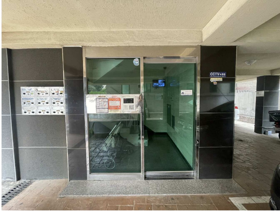
기호(2) 공동출입구 전경
