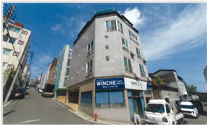
[주위 전경 - 남동측에서 촬영]
