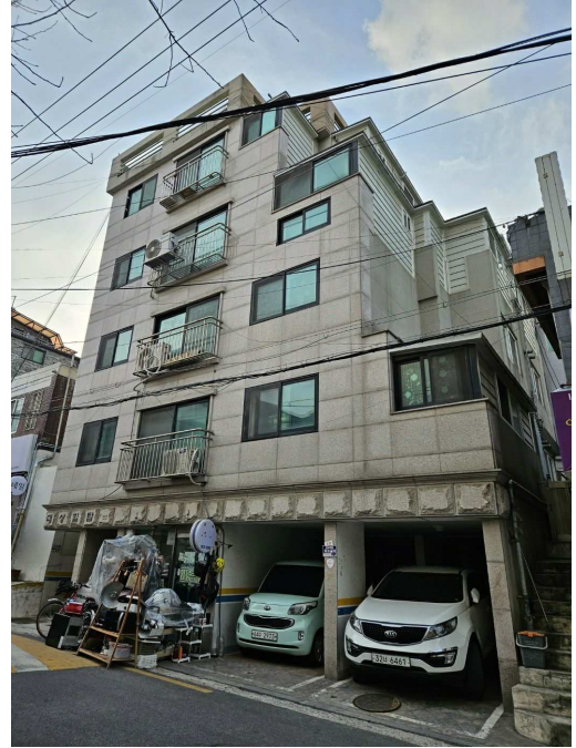
대상물건 소재 건물
