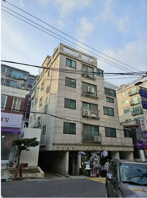
대상물건 소재 건물
