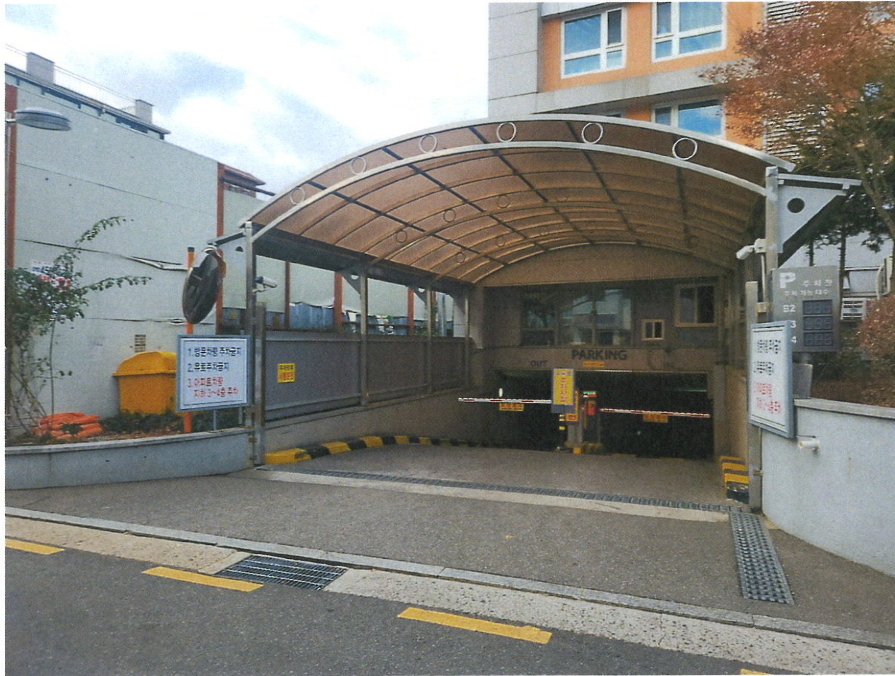
본건동 지하주차장 출입구 전경
