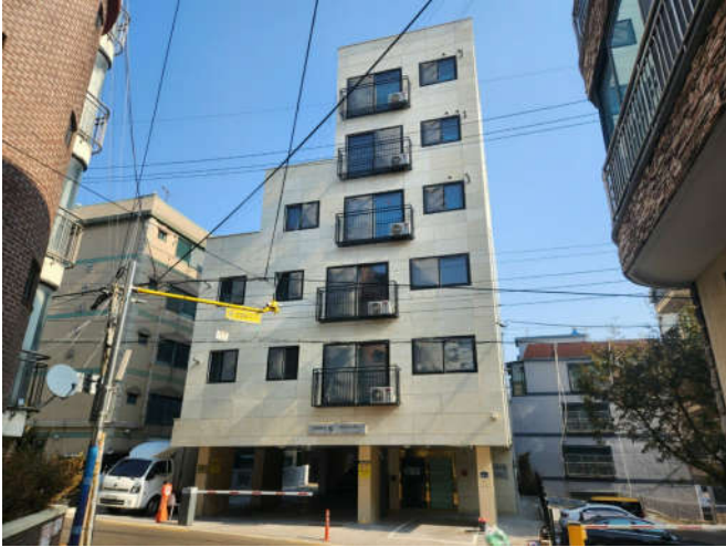
대상물건 소재 건물
