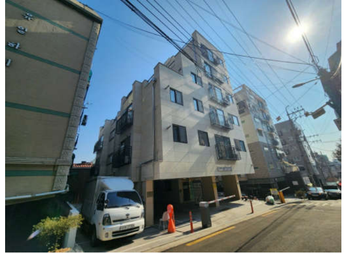
대상물건 소재 건물
