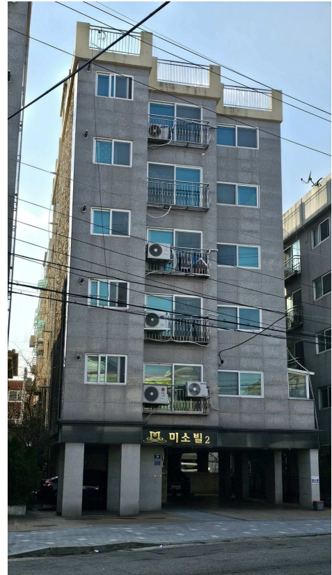
< 남동측에서 본 본건 소재 건물 전경 >
