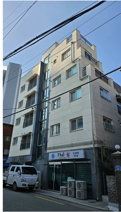
< 남동측에서 본 본건 소재 건물 전경 >
