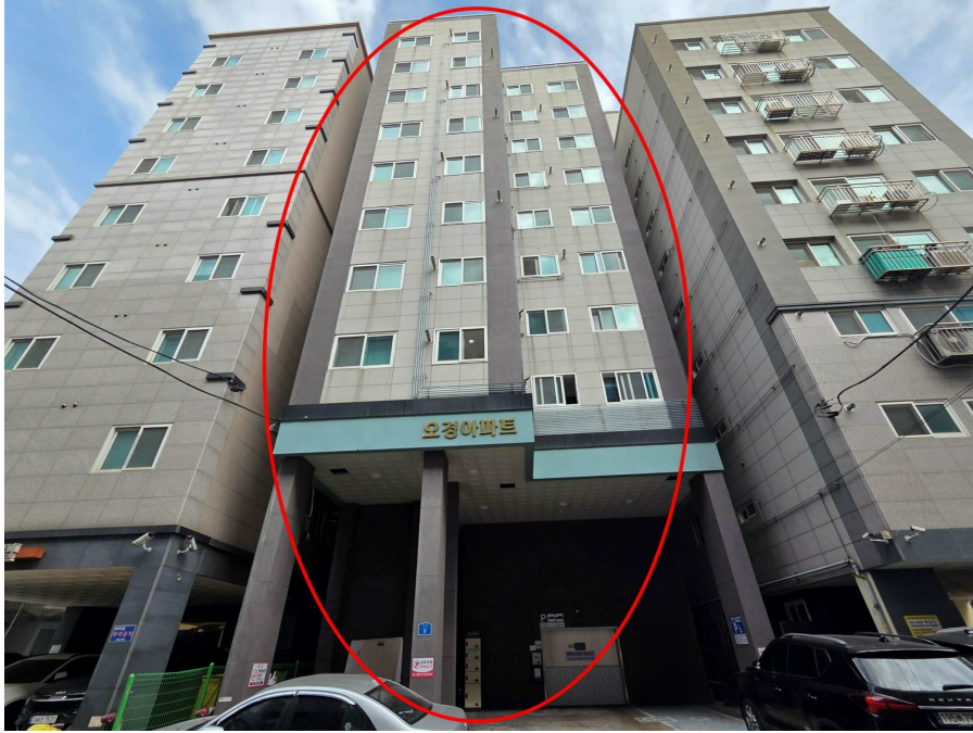
본건 건물 전경
