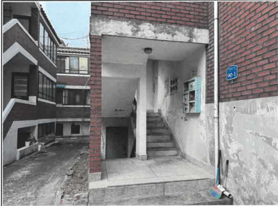
대상물건 건물 출입구
