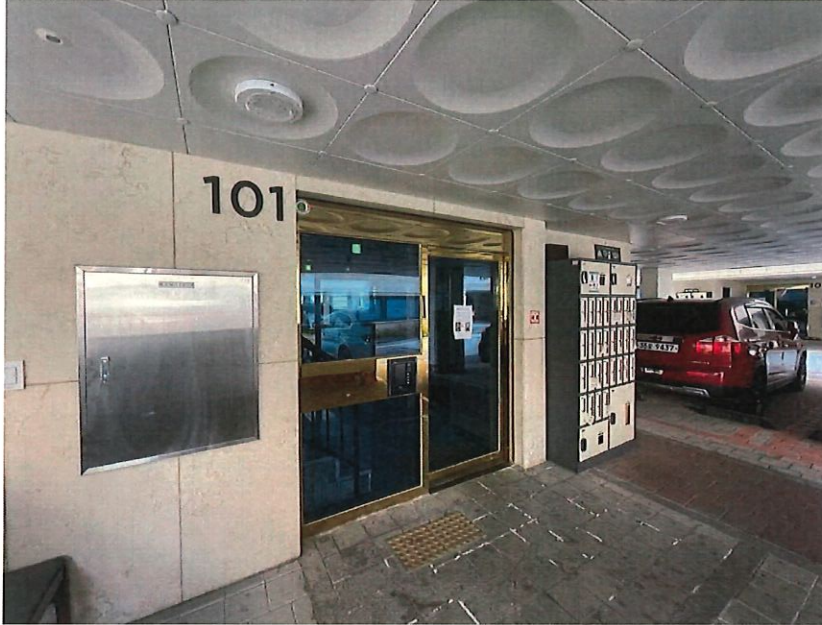
본건 1층 출입구
