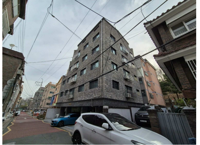
남서측에서 촬영한 본건 건물 전경
