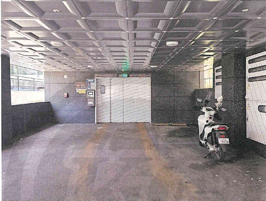
본건물내 주차타워 전경
