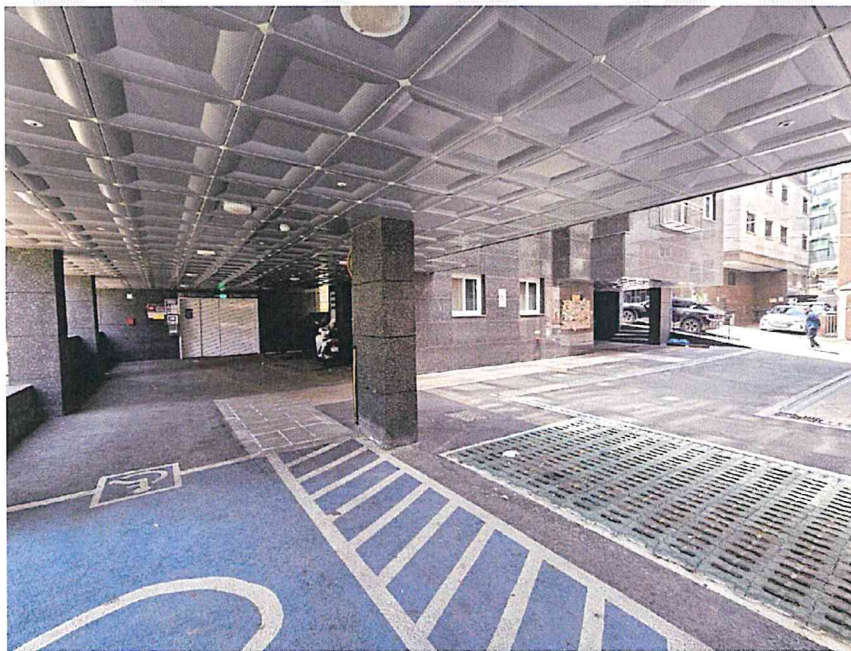
본건물내 1층 주차장 전경
