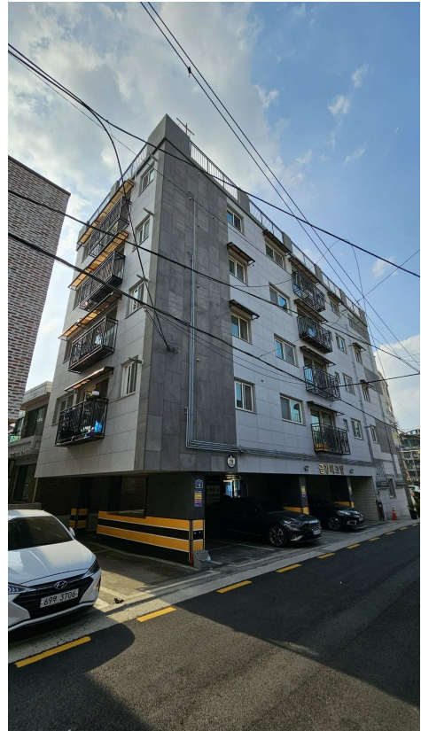
< 남동측에서 본 본건 소재 건물 전경 >
