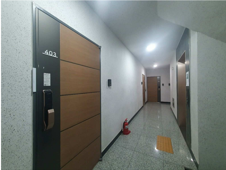
본건 앞 복도 전경
