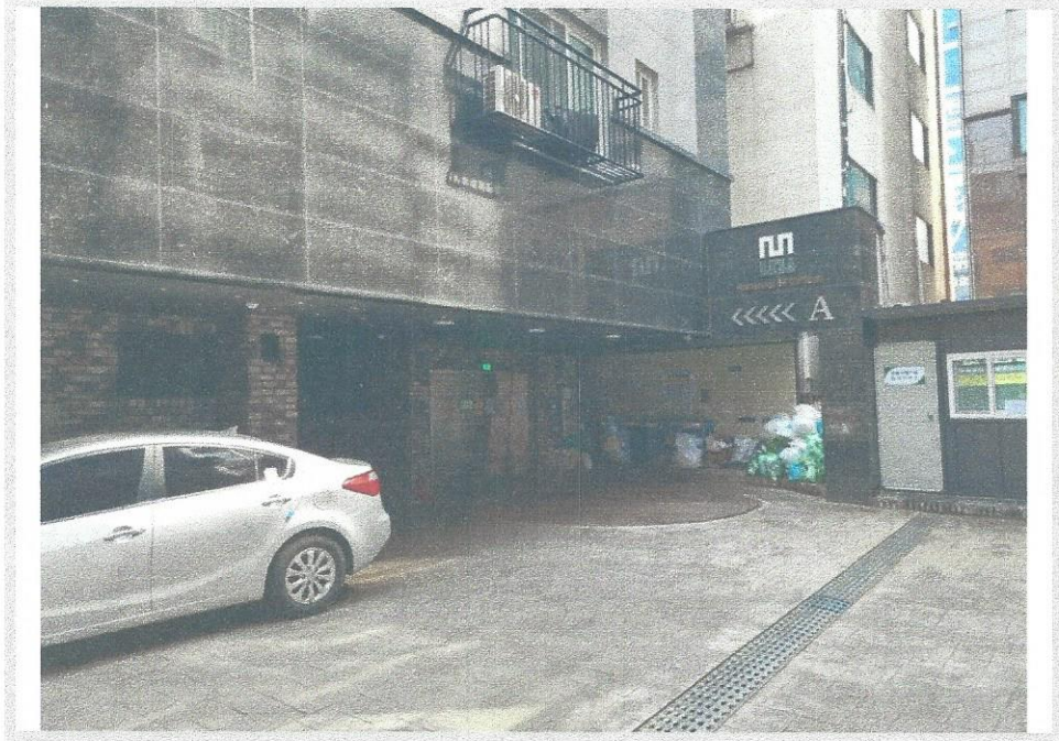
한올에이치밸리움 제에이동 주차장 및 외부출입구
