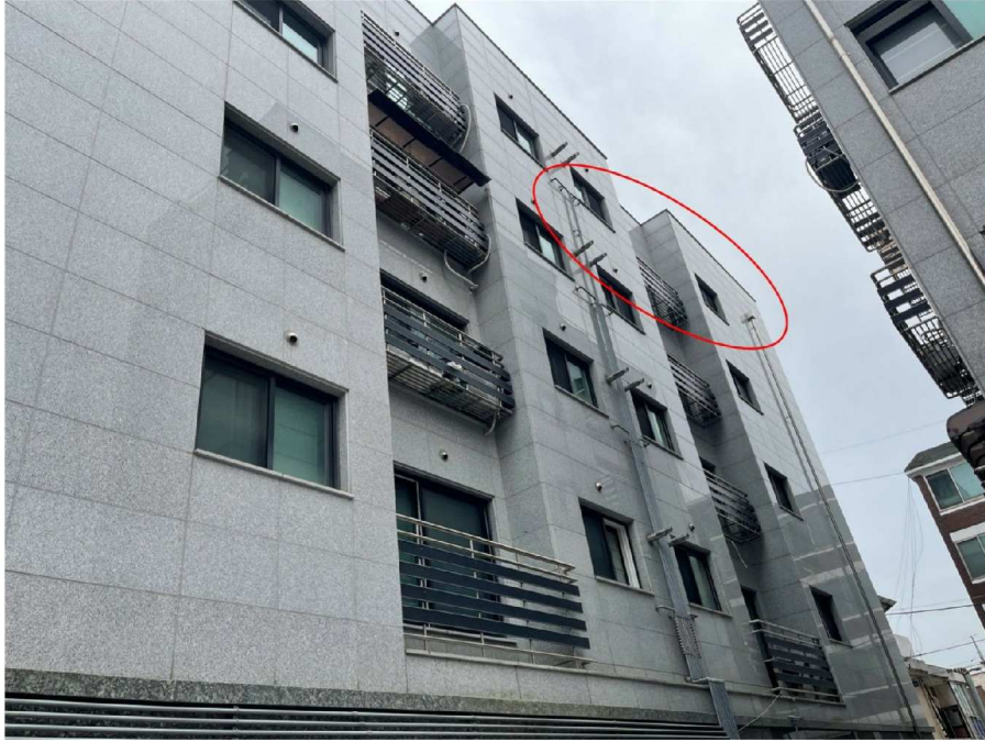
본건 북측 전경
