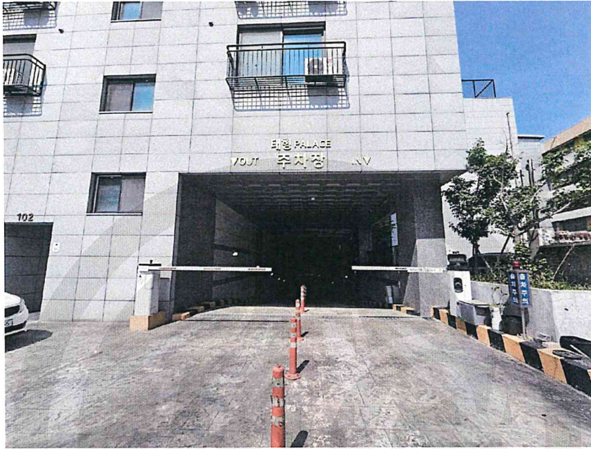
본건물내 주차장 입구 전경
