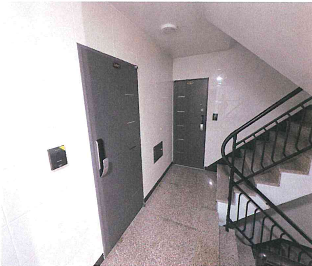
[ 제3층 복도 전경 ]
