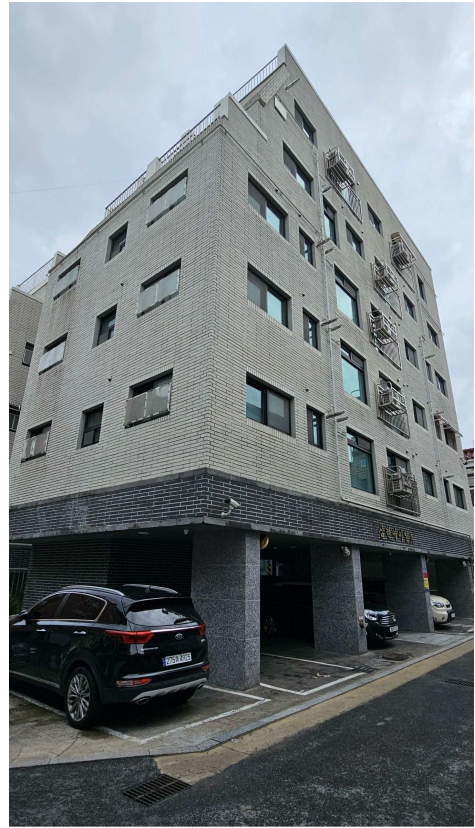
< 북서측에서 본 본건 소재 건물 전경 >
