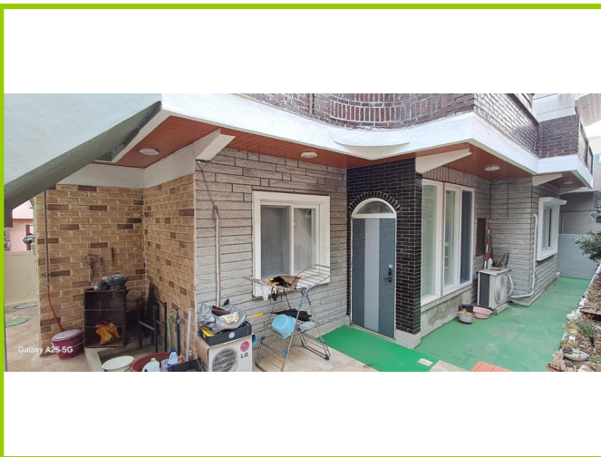
본건 일련번호(1) 전경(1층: 주택)
