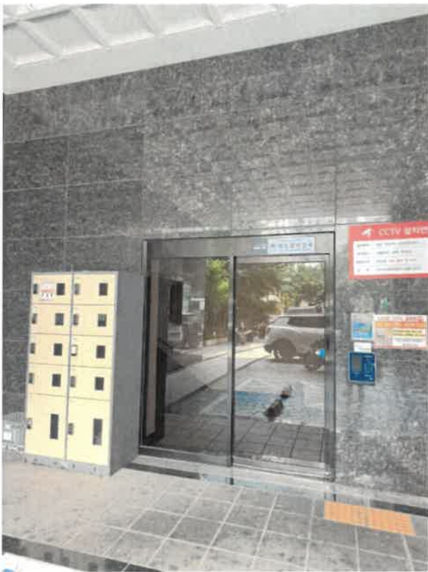
본건 102동 1층 출입구
