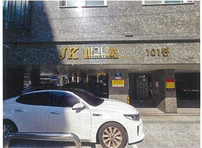
본건 1층 출입구
