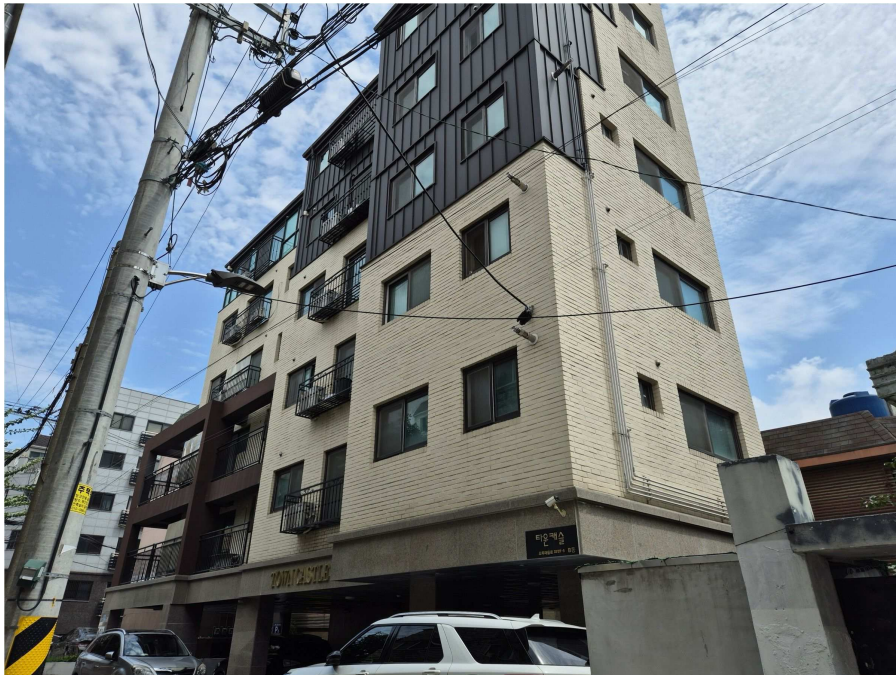
본건(타운캐슬 B동) 전경(서측-> 동측방향)
