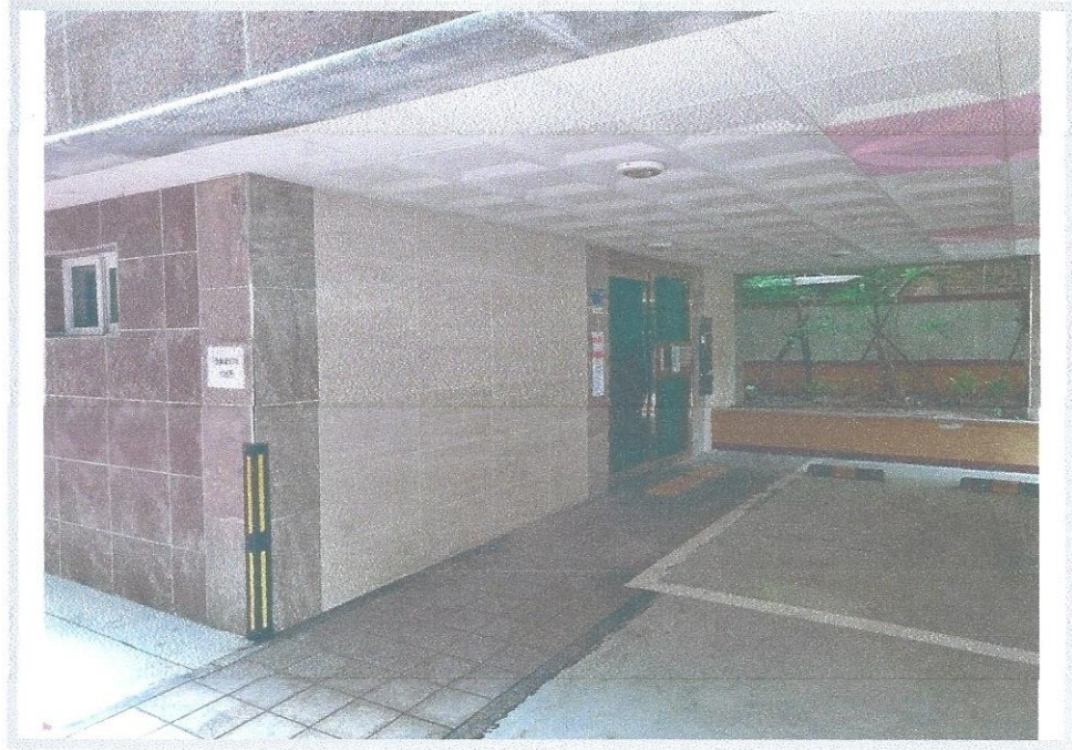
청솔필리체 제105동 제1층(외부출입구 및 주차장)
