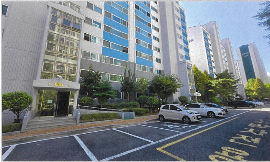
3. 본건 1층 출입구
