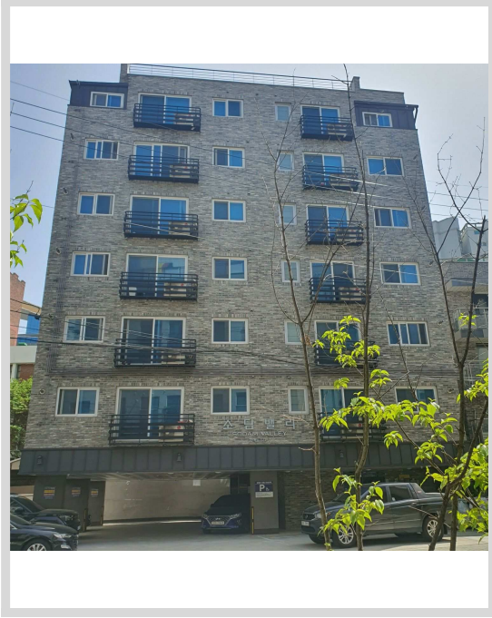
본건 전면 전경
