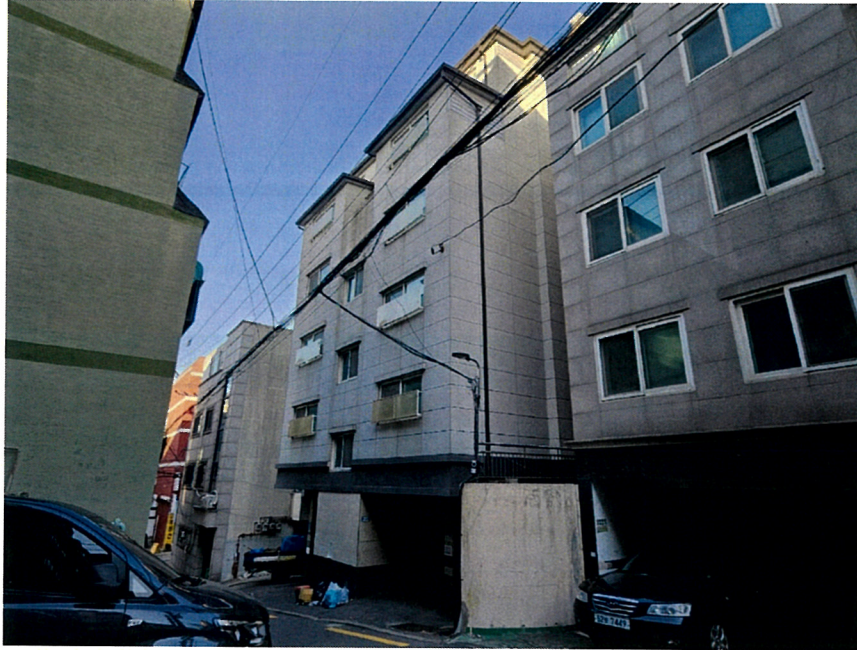
본건이 속한 건물 전경 (북서측)
