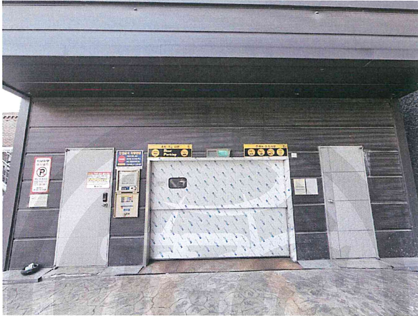
본건물내 주차타워 전경
