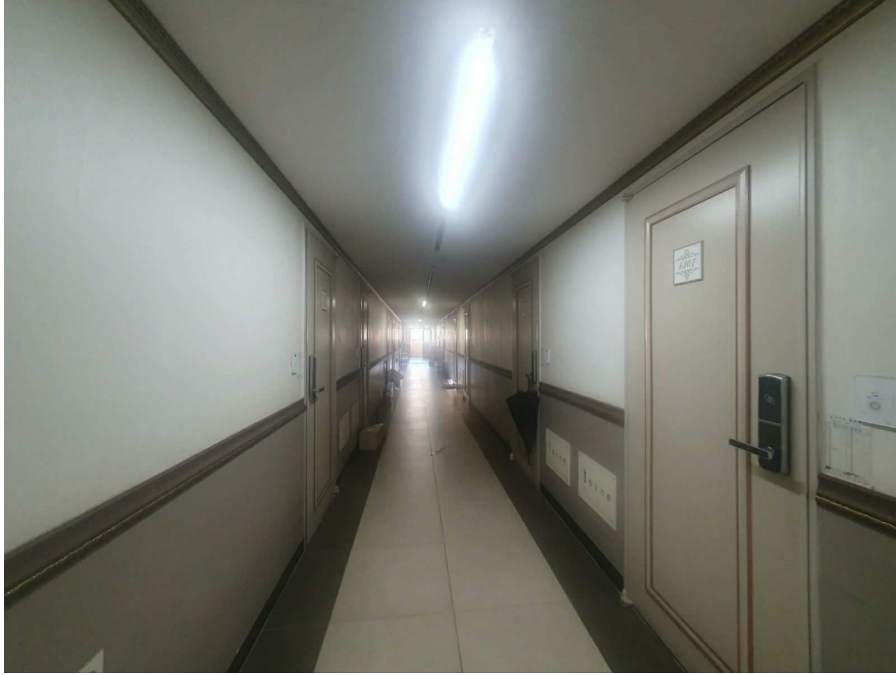
본건 앞 복도 전경
