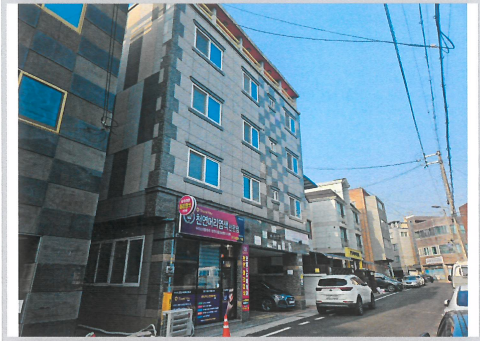
본건 전경 (북동측에서 촬영)
