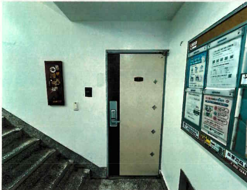
【2. 본건 현관문 전경】
