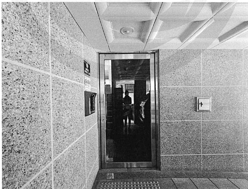
본건물내 공동출입구 전경
