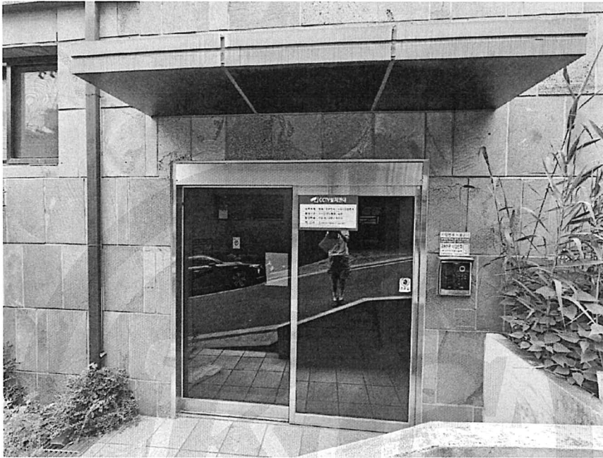
본건물내 공동출입구 전경
