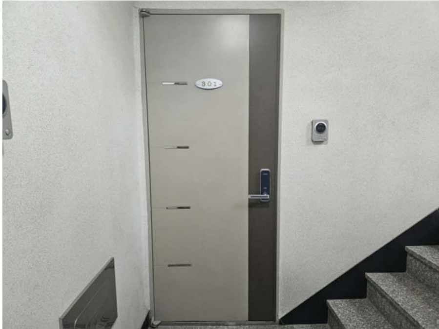
[ 일련번호 3 현관문 전경 ]
