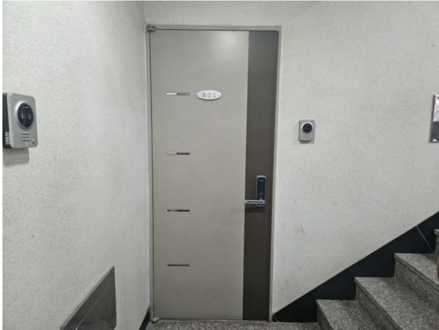
[ 일련번호 1 현관문 전경 ]
