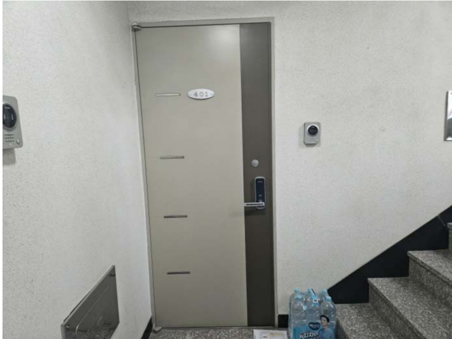
[ 일련번호 5 현관문 전경 ]
