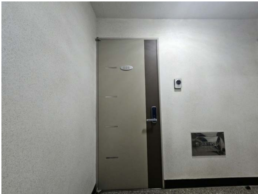
[ 일련번호 2 현관문 전경 ]
