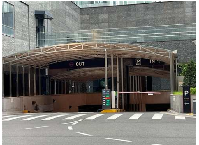
본 건물 주차장 출입구
