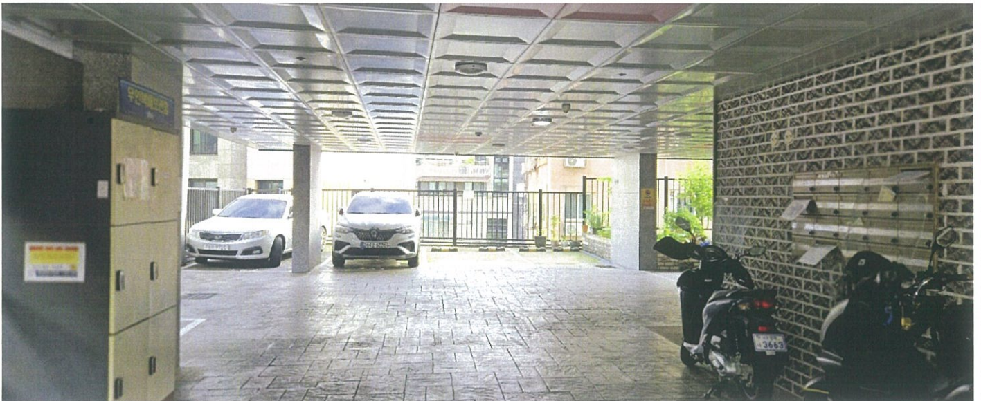
본건 1층 주차장 전경
