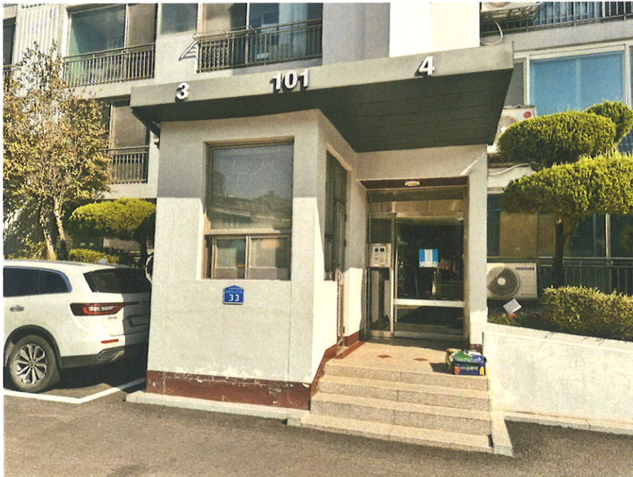
본건 소재 건물 공동출입구
