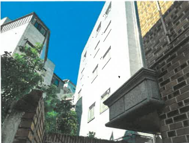
[제시외 건물(확장형발코니) 전경]
