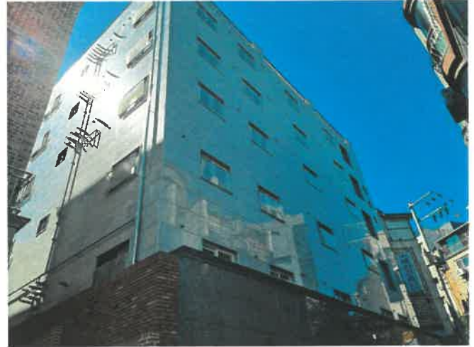
[제시외 건물(확장형발코니) 전경]
