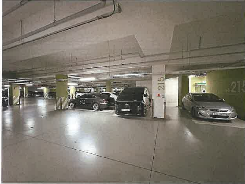
본건 지하주차장 전경
