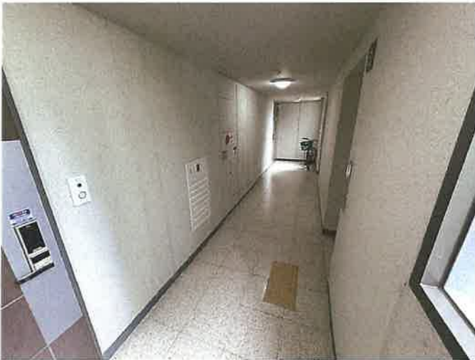
본건 제5층 복도 전경
