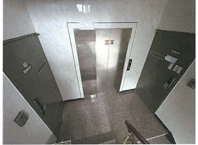
본건 제6층 복도 전경
