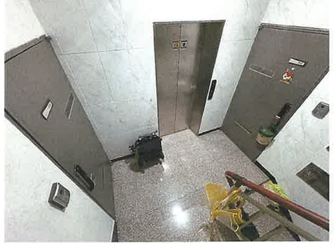
본건 제2층 복도 전경
