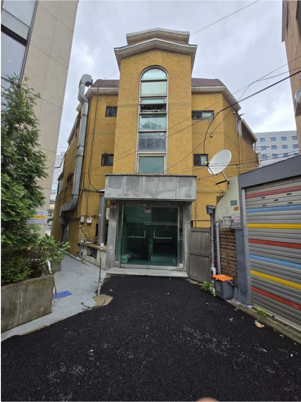
본건 전경 (2,3층 출입구)
